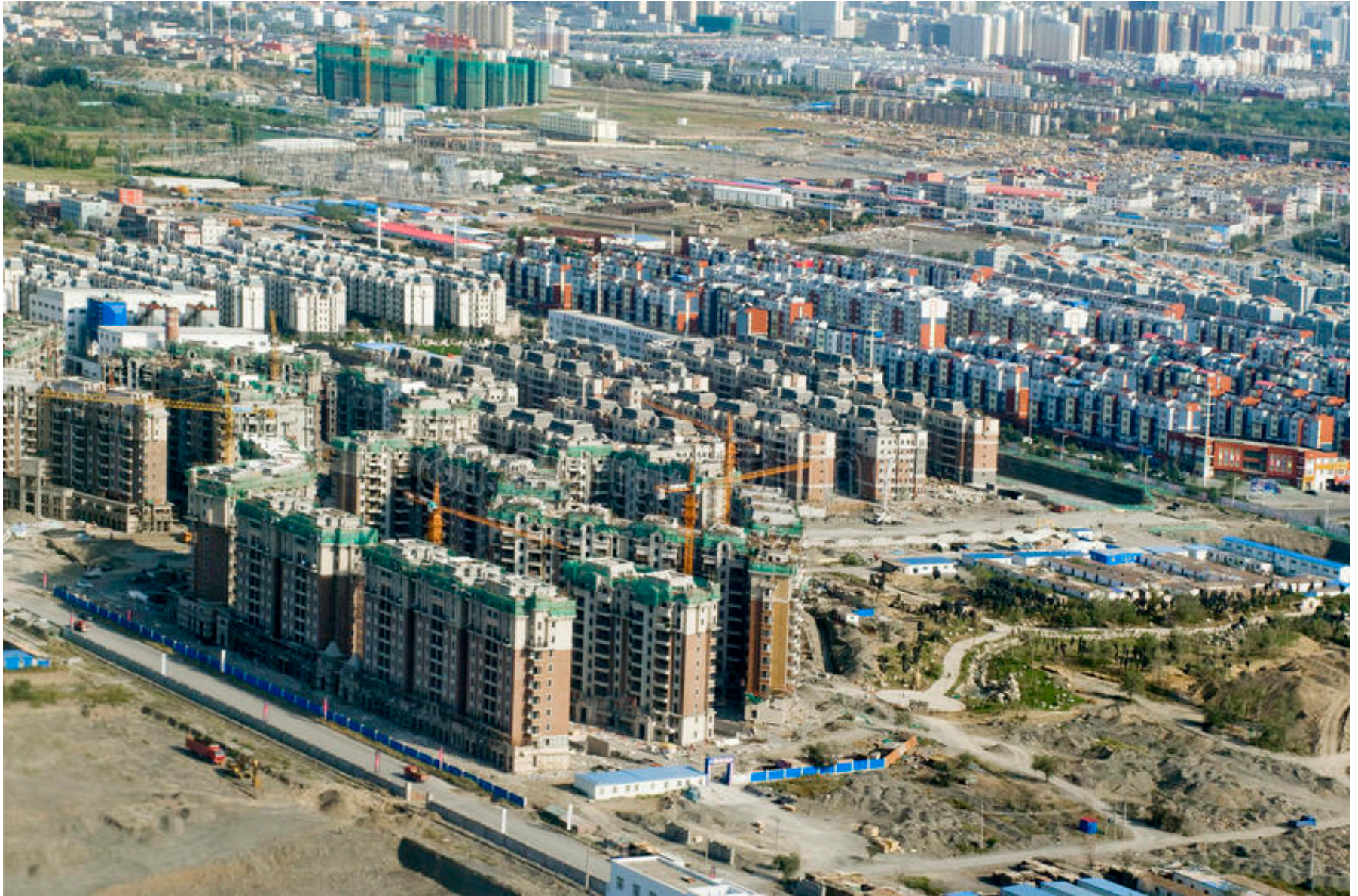
Chantier urbain en chine
